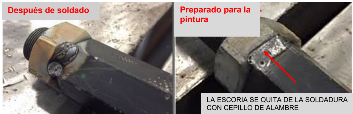
Figura 3: Ensamblaje de la barra de acoplamiento con el remedio de la soldadura completado
